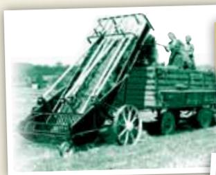
Le chargeur à foin de 1950 a servi de base pour développer ensuite les autochargeuses.
