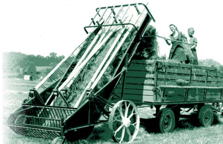
Ve svých počátcích vyvinula firma Pöttinger řadu nakládacích strojů pro seno a další druhy krmiv, tažených koňmi. Nakladač na obrázku byl přímým předchůdcem samosběracích návěsů Pöttinger
