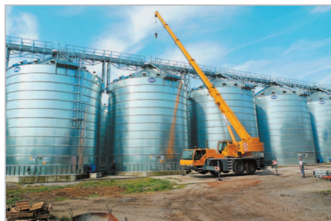
V loňském roce dokončilo družstvo druhou etapu výstavby skladovacích sil s provzdušněním o celkové kapacitě přes 10 000 tun Foto archiv
