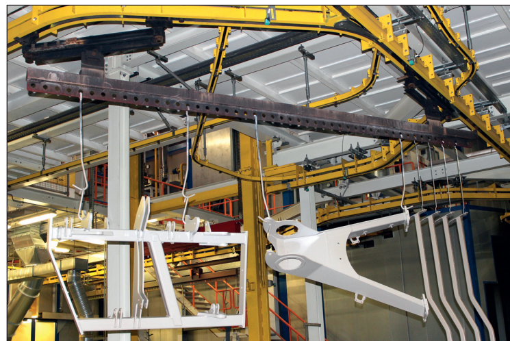
Navěšené malé dílce, opatřené základovou barvou, putují na držácích do práškovacího boxu
