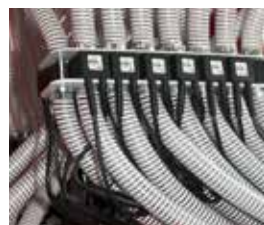
Kontrola průchodnosti osiva
